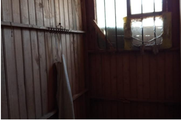
Al interno, della antica casa.Y la demolizione
